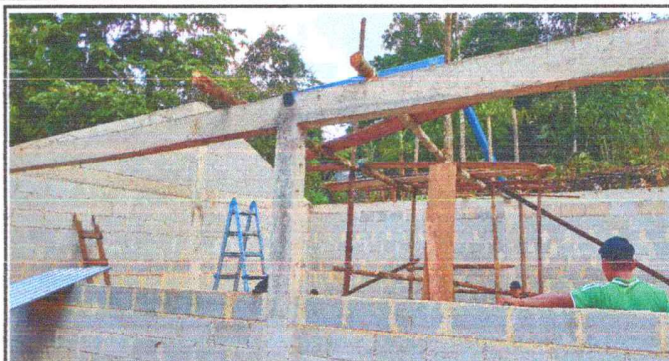
Foto 2: se mejoro la estructura del techo.
