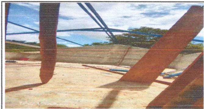
Foto 4: Colocacion de costaneras.
