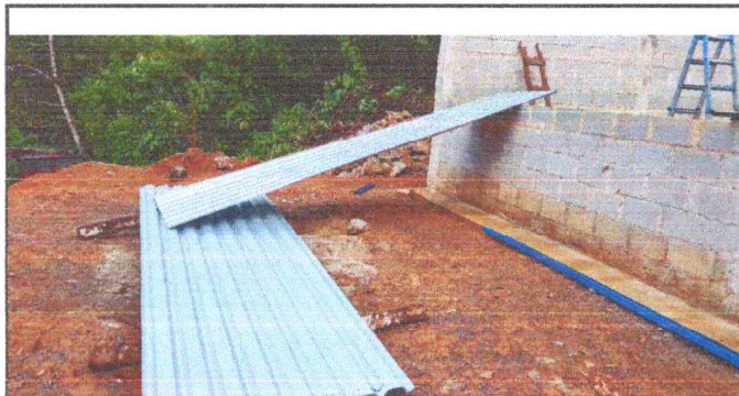
Foto 3: Se sustituyeron laminas viejas por nuevas laminas.
