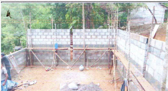
Foto1: Se mejoro y se sustituyo paredes.
